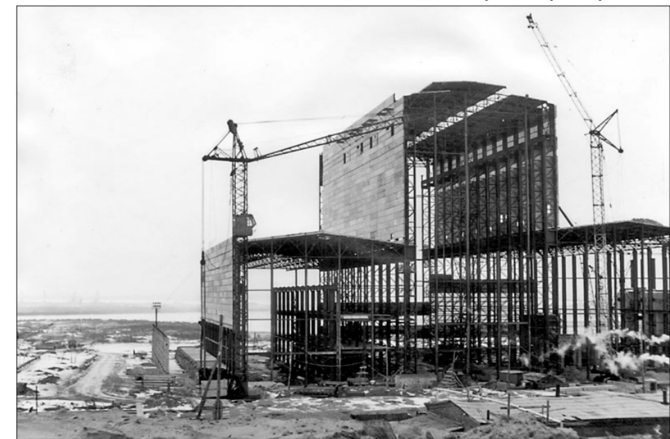
На строительстве III очереди Архангельского ЦБК, фото первой половины 1970-х годов
