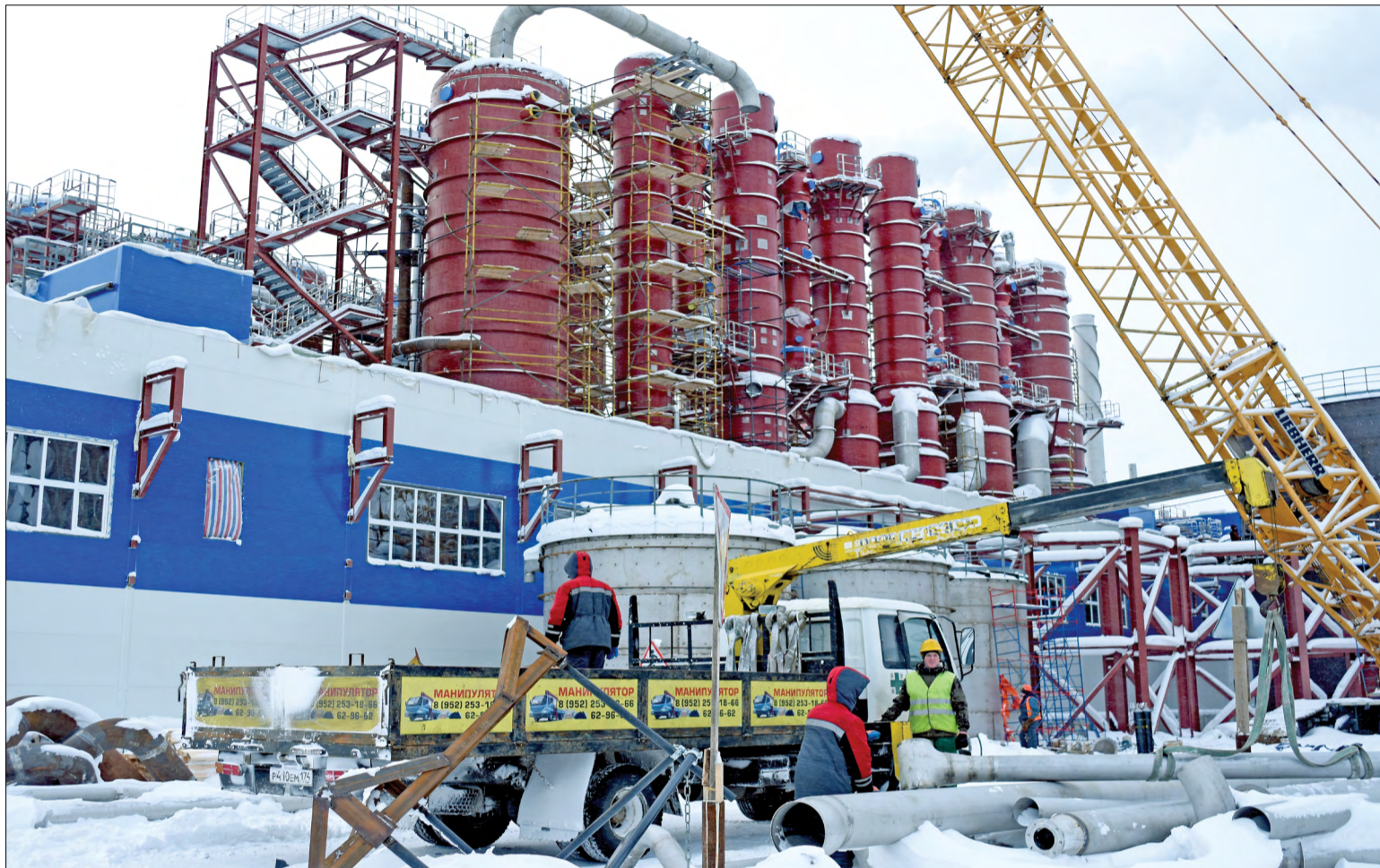
ВОЗВОДИТСЯ новая выпарная станция комбината
