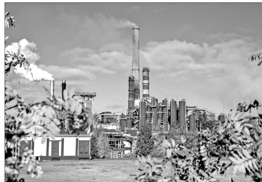
Строительство выпарной станции производства картона Архангельского ЦБК. Работы ведутся по проекту Архгипробума. Пуск объекта состоялся в августе 2020 года
