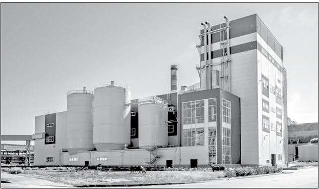
Участок (цех) по производству полуцеллюлозы блока цехов производства картона АЦБК
