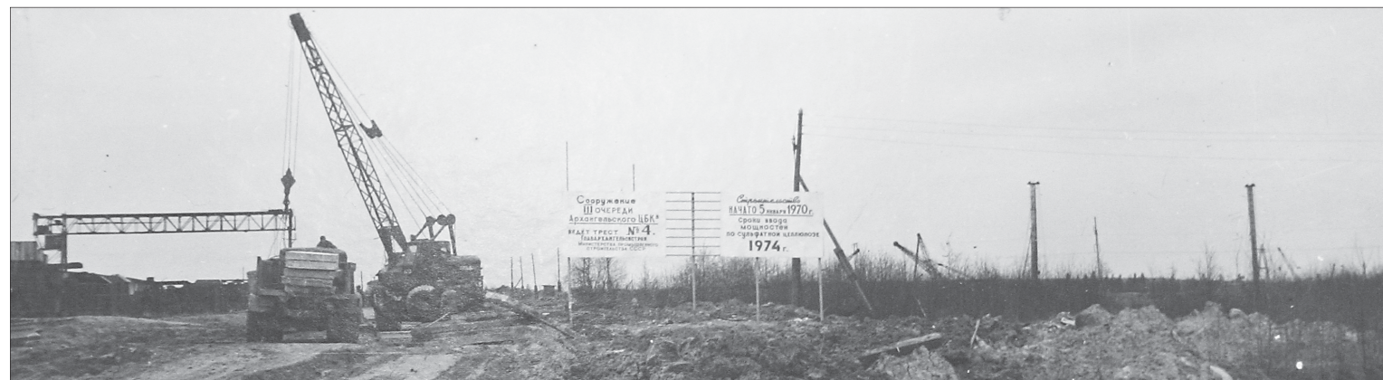
На строительстве третьей очереди Архангельского ЦБК, фото 1970 года
