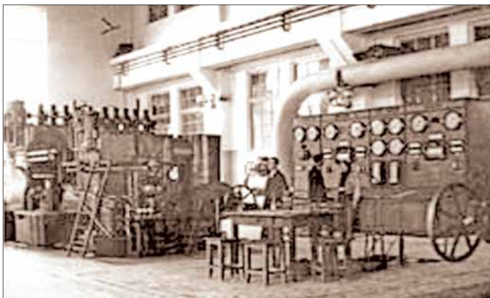
На пульте теплоэлектроцентрали АБК, 1940-е годы
