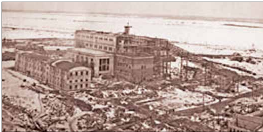
Панорама площадки Архбумкомбината. В центре – ТЭЦ
