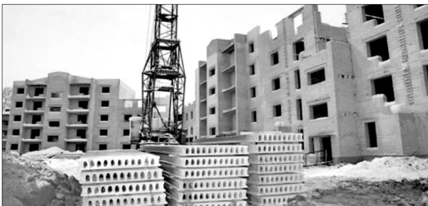
В феврале подрядчик планирует закончить кирпичную кладку стен, а также приступить к устройству кровли и окон. Кроме того, продолжатся работы по монтажу наружных инженерных коммуникаций.
